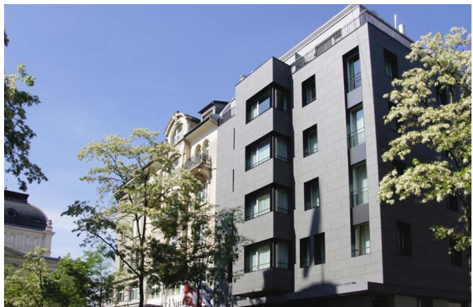
Das 4-Sterne-Hotel Opera an der Dufourstrasse 3/5 in Zürich.
