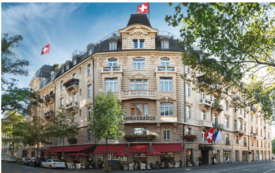
Das «Small Luxury 4-Sterne-Hotel Ambassador» an der Falkenstrasse 6/Ecke Dufourstrasse in Zürich.
