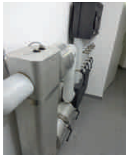
Fig. 3 Hydraulische Weiche mit einem Teil der Weishaupt-Verteiler-Elemente
