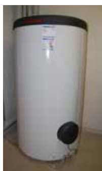
Der Trinkwasserspeicher mit 300 Liter Inhalt sorgt für einen hohen Warmwasserkomfort. Ein grosses Speichervolumen erlaubt angenehme Warmwassertemperaturen und hilft, Energie zu sparen.
