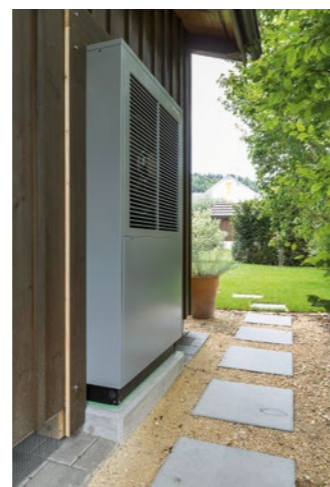
Aussenansicht der speziellen Einbaulösung auf einem Sockel.
