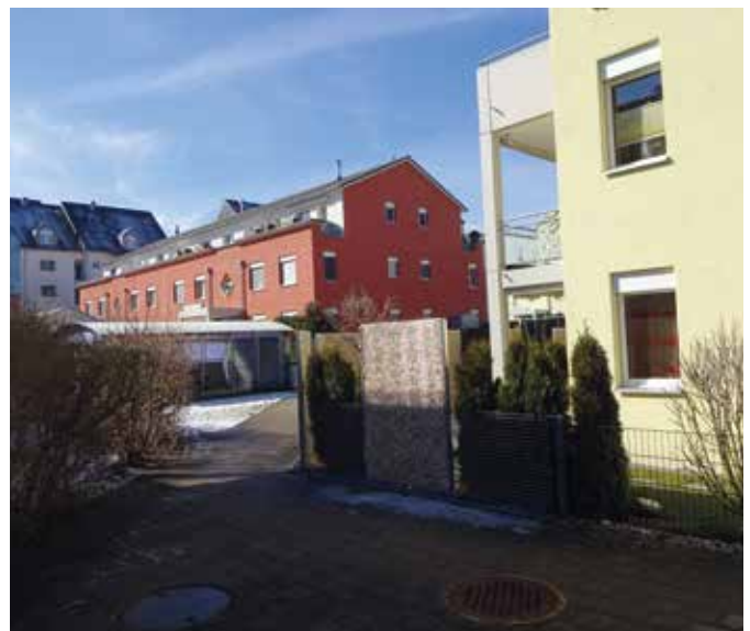
Einer der Blöcke der Siedlung
