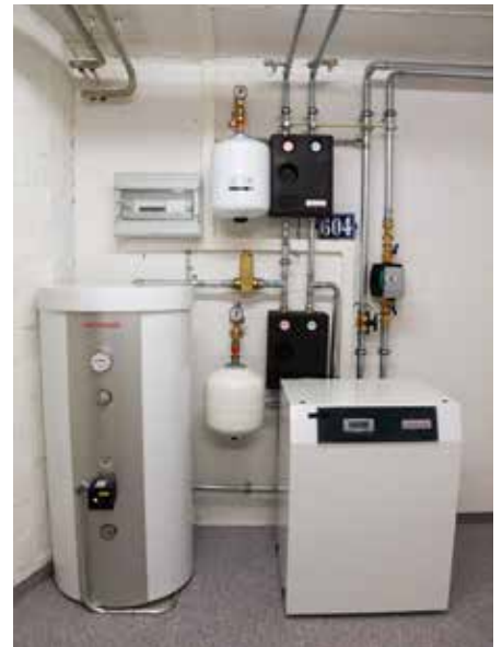
Weishaupt Sole/Wasser-Wärmepumpe WWP S 8 ID (Sole/Wasser) mit einer Wärmeleistung von 8,1 kW und einem 200 l Energiespeicher WES 200 Eco/WP.
