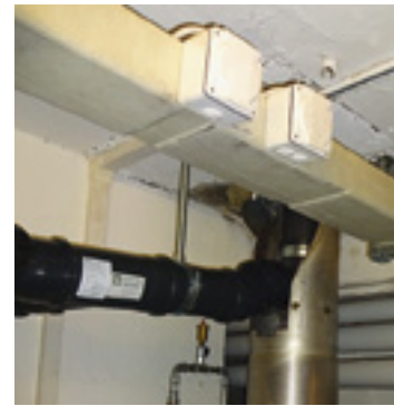
Kunststoff-Abgasleitung im alten Chromstahlkamin.
