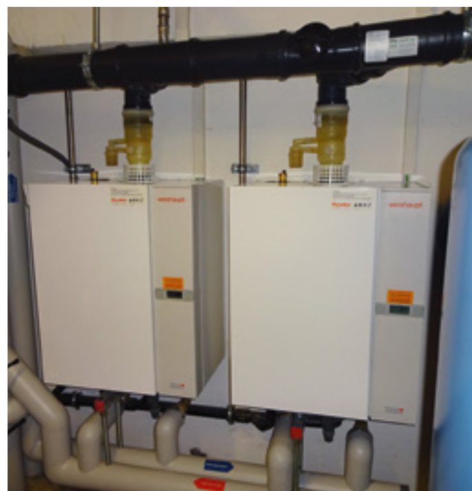
Ein Weishaupt WTC 60A und ein WTC 45A Gas-Brennwert-Wandkessel in der Dachzentrale des Hotels Opera.
