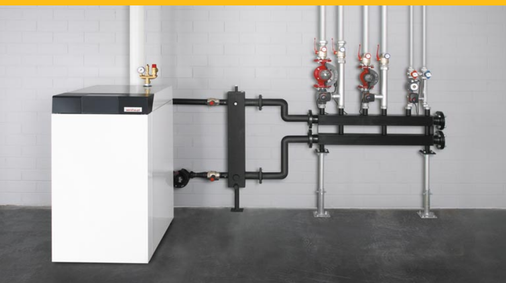
Gazowy kocioł kondensacyjny WTC-GB z komponentami hydraulicznymi (bez izolacji termicznej)
