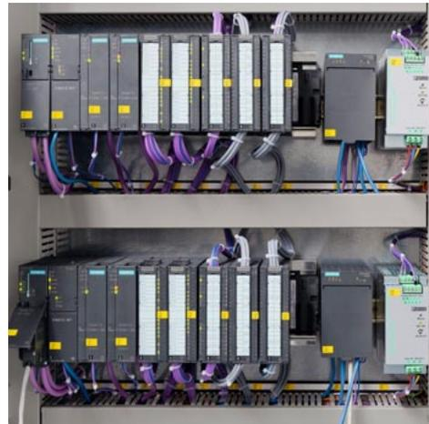
Höchste Sicherheit auch durch redundante Steuerungen
