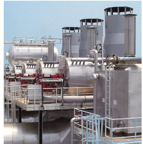
Vier RGL 70 Brenner stellen über Thermoölkessel die Pumpfähigkeit des Rohöls sicher
