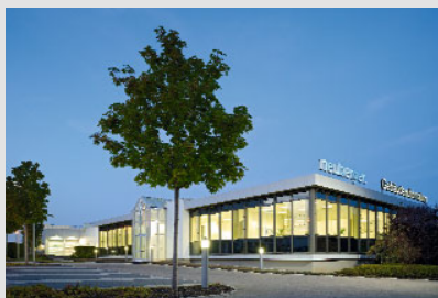
Building Automation di Neuberger Gebäudeautomation, Rothenburg o. d. T.
