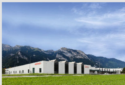
Caldaje a condensazione e bollitori, fabbrica a Sennwald (Svizzera)
